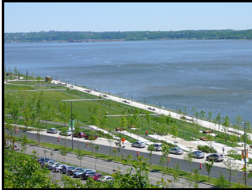
Photo 7 – Vue d'ensemble d'une partie de la Promenade Champlain
